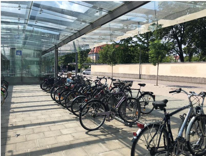
Abbildung 39: Fahrradabstellanlage Park+Ride Anlage Westfriedhof (Eigene Aufnahme)
