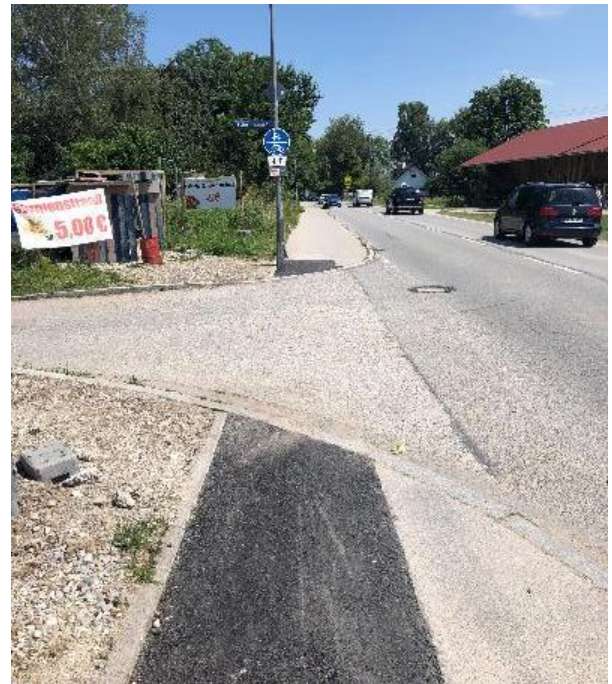
Abbildung 56: Enger gemeinsamer Geh- und Radweg für zwei Richtungen (Lochhausener Straße) (Eigene Aufnahme)
