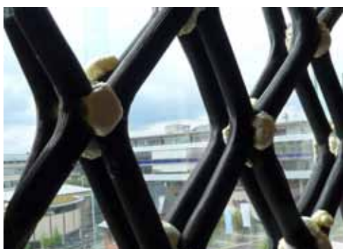
Wandstruktur aus geschäumten Textilschläuchen
