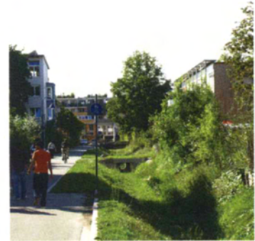
Figura 10: Infiltración de aguas pluviales en Vauban. Rainwater and surface water infiltration in Vauban.
