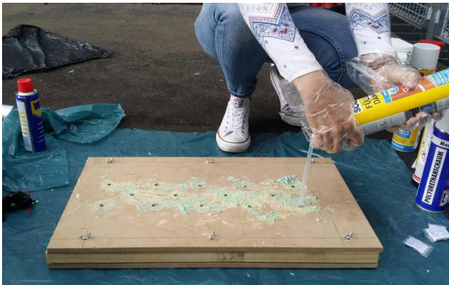
Abb. 2 Schaum in die Löcher einspritzen
