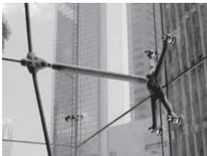
Punktförmig gehaltene Fassade 3, Pacific Place, Hong Kong)
